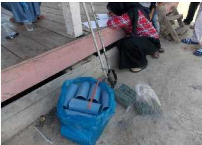
Gambar 4.1 Sebagian alat dan bahan yang digunakan dalam pembuatan lubang biopori di halaman masjid dusun melur aceh tamiang.
