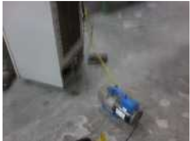
Gambar 8 Sistem pemipaan pada kulkas sedang dilakukan pemvaccum
